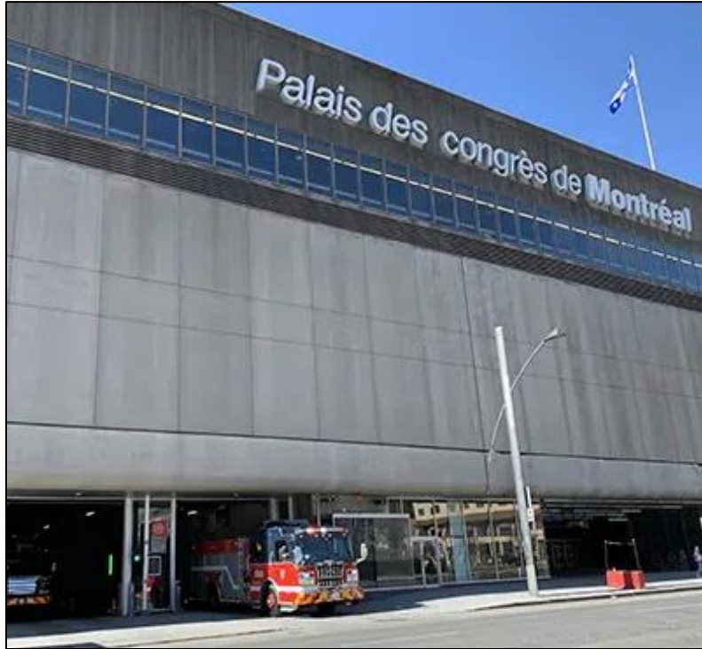
Figure 4 – Palais des congrès de Montréal Fire Station
